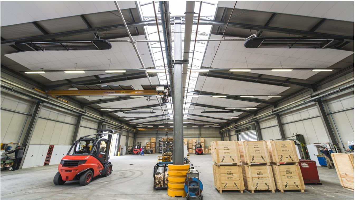
Rasterdecken bestehen aus einem von der Decke abgehängten T-Schienensystem mit eingelegten Schallabsorbern. Sie werden in zwei Varianten ausgeführt: Entweder als Deckenspiegel oder als geschlossene Decke. Durch die Verwendung von Schallabsorbern aus dBtec® Resistant Material entsprechen Rasterdecken der Brandklasse A – nicht brennbar, sind abwaschbar und können in Reinräumen sowie für die Lebensmittelproduktion eingesetzt werden.
