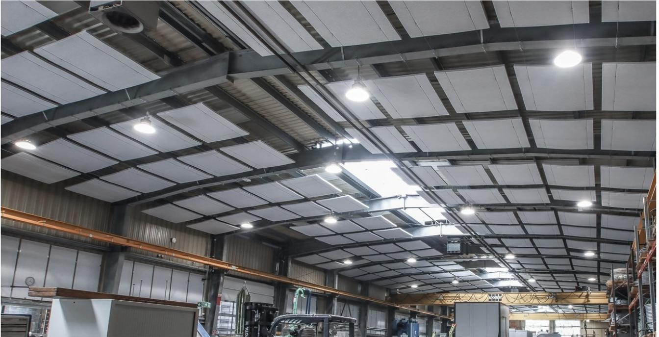
Durch die Montage von Industriedeckensegeln werden Schallreflexionen von der Decke stark reduziert, und so der Lärm an den Arbeitsplätzen deutlich verringert. Industriedeckensegel werden horizontal abgehängt und an Stahlseilen unterhalb der Decke montiert. Das revisionierbare System ermöglicht kurze Montagezeiten, hervorragende Schallabsorption, Brandklasse und günstige Gesamtkosten für Neubau und Nachrüstung.
