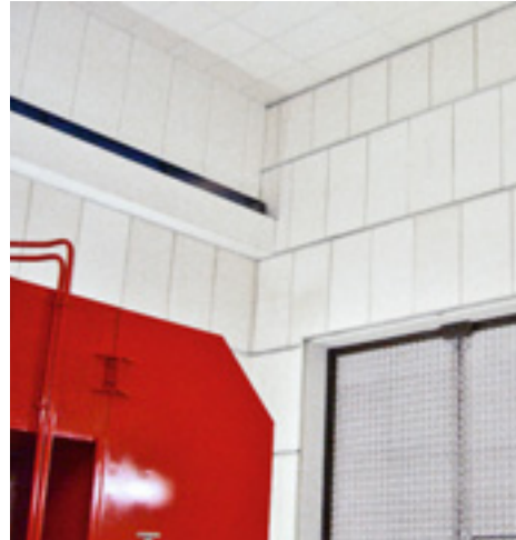
Decken- und Wandverkleidung mit Illbruck-Absorbieren
